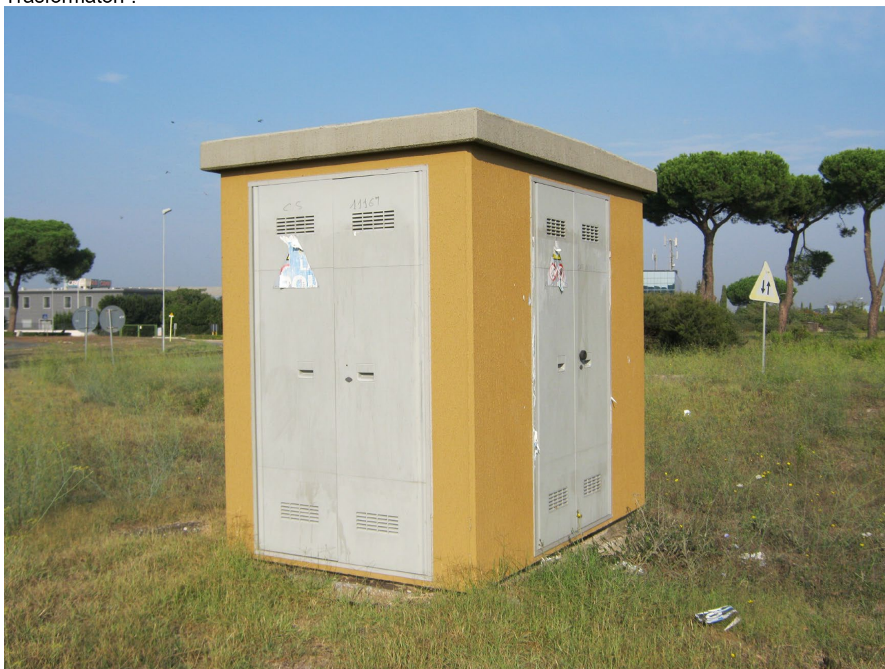
Figura 1) _esempio di cabina elettrica "a chiosco" con tre aperture
